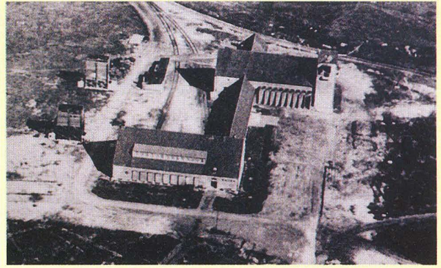
Obr. 6. Vysílací centrum na velmi dlouhých vlnách (15 až 60 kHz) „Goliáš“ s výkonem 1 MW; vysílal mimo jiné i impulsy pro časovou synchronizaci ponorek
